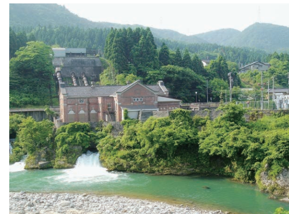
1911年に建設された福岡第一発電所 The Fukuoka Dai-Ichi Power Station, Built in 1911
