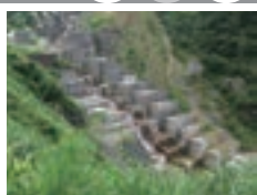
柳谷導流落差工
