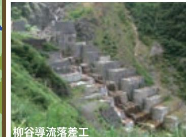
砂防新道沿いの中飯場などから、柳谷に造られた砂防堰堤群などを見ることができます。砂防堰堤に土砂が貯まることで、谷の浸食や斜面の崩壊を防いでいます。
