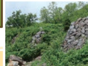
南竜道分岐の近くでは、白山砂防の中で最初期に造られた谷止工の一つを見ることができます。標高2,000mを超える高地の施設で、当時は日本で最高所の砂防施設でした。
